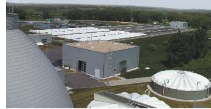
Depuradora de aguas residuales Halle-Nord de la Halleschen Wasser und Abwasser GmbH
